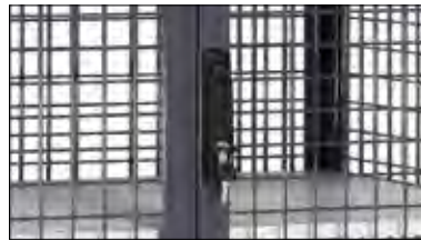
Treibriegelverschluss mit Schwenkhebel und Zylinderschloss.
